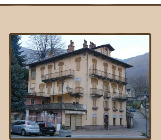
Edificio residenziale P.zza Garibaldi - VICO Capoluogo
