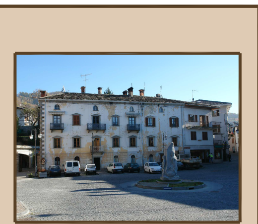
Edificio residenziale P.zza Garibaldi - VICO Capoluogo
