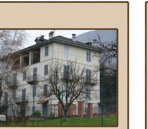
Edificio residenziale S.P. 64 - NOVAREGLIA
