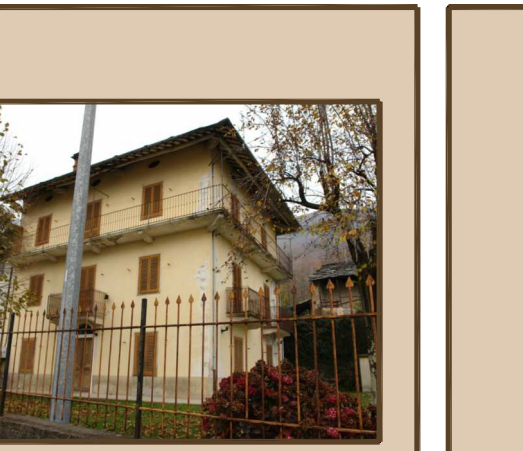
Edificio residenziale DRUSACCO
